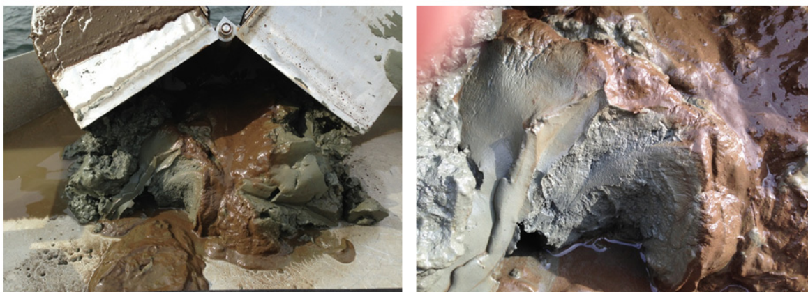
Figur 11. Sediment fra en RU-stasjonen. Sedimentet består av grå leire/silt med et brunt overflatelag.
