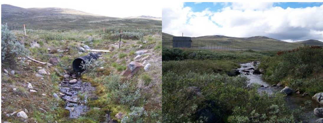
Figur 21. NØ-bekken ved stasjon B2 ved HFK-sletta's nord-østre hjørne (Fig.1,19) og NV-bekken ved bua (st.B3) og samløpet med NØ-bekken før utløpet i Grisungbekken (fig.1,19) (foto S. Rognerud)
