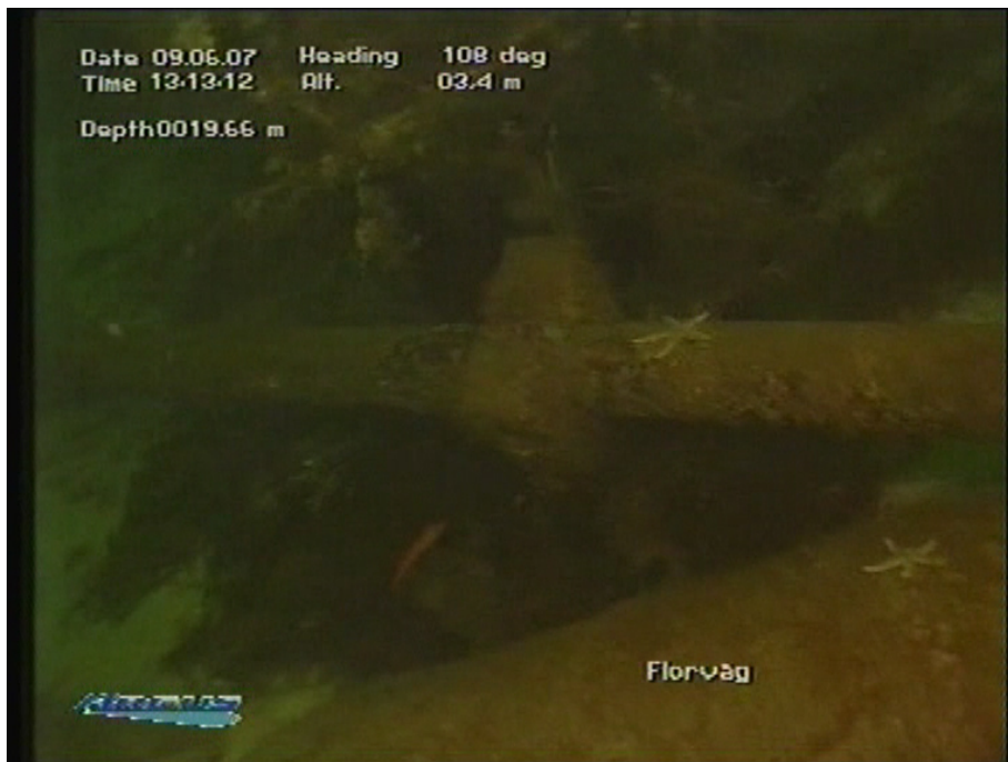
Figur 65. Florvåg: En stein ligger inn mot ledningen på ca. 20 m dyp
