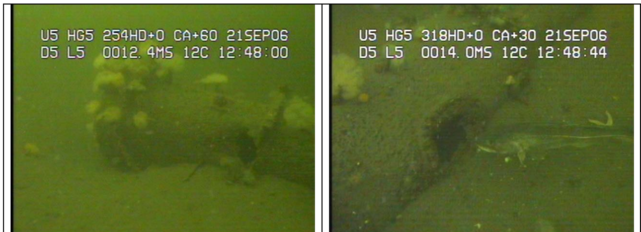
Figur 18. Bleikøyflu, kjøring 6. Gammelt avløpsrør på ca. 15m dyp. En stor torsk hadde tilholdssted inne i røret.
