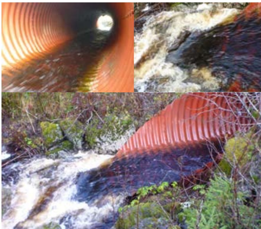
Figur 59. Kulvert under Fv 723 er fiskeførende for stor gytefisk på over middels vannføring, men vandringsvinduet er innsnevret sammenlignet med naturtilstand. (Foto: Morten Bergan)
