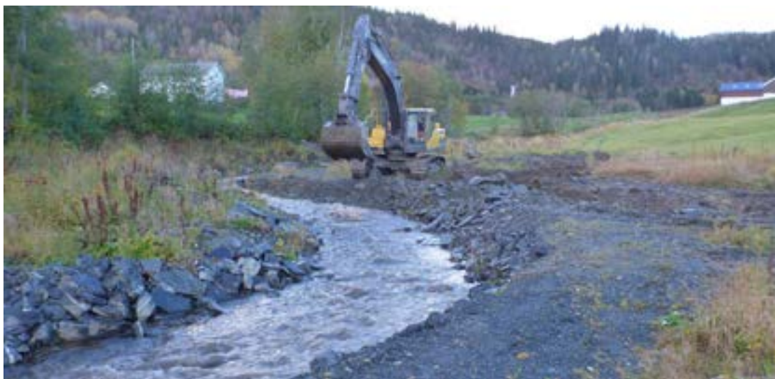
Figur 5. Øvre, nylig steinsatte strekninger av Prestelva, og pågående anleggsarbeid i og ved elva midt i gytetiden for sjøørret og laks. (Foto: M. Bergan)
