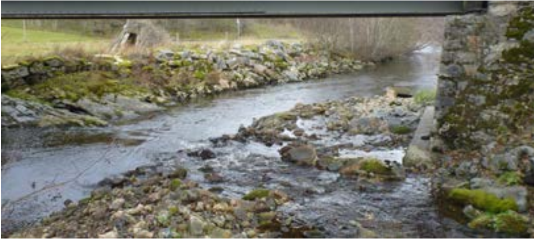
Figur 70. Straumselva i området Fv. 14, med munning av Kvernelva nederst til høyre i bildet. (Foto: Morten Bergan)
