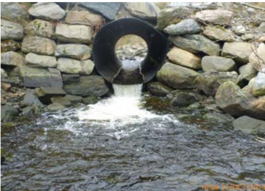
Figur 63. Kulvert i Sætranselva før munning til sjø.
