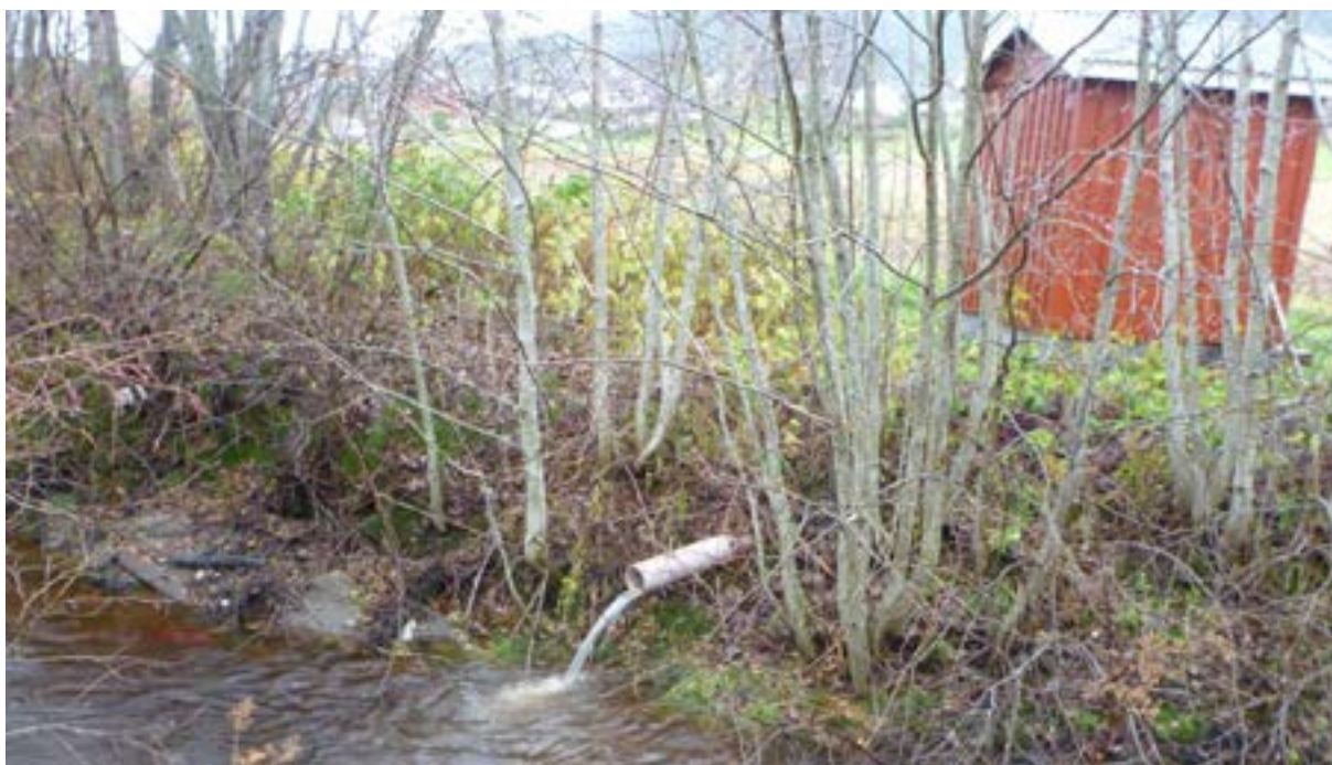
Figur 54. Flere utslippsrør med potensiell sanitært avløpsvann går rett i Hubekken, her fra strekninger nedstrøms Fv. 50. (Foto: Morten Bergan)
