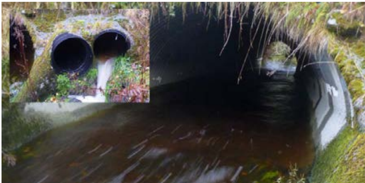
Figur 55. Kulvert under Fv 50 har tilfredsstillende vandringsmuligheter for de fleste fiskestørrelser. Innfelt: Overløpsrør fra området rundt Mekonomen/Trønderbilene AS fører sanitært avløpsvann og oljeholdige substanser ut i Hubekken. (Foto: Morten Bergan)
