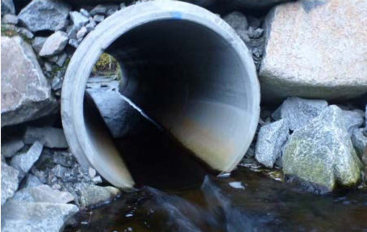
Figur 95. Nyanlagt krysning under privat grusvei (?) er vandringshindrende for oppgangsfisk av sjørørret, men fisken kommer forbi på gunstig vannføring. (Foto: Morten Bergan)
