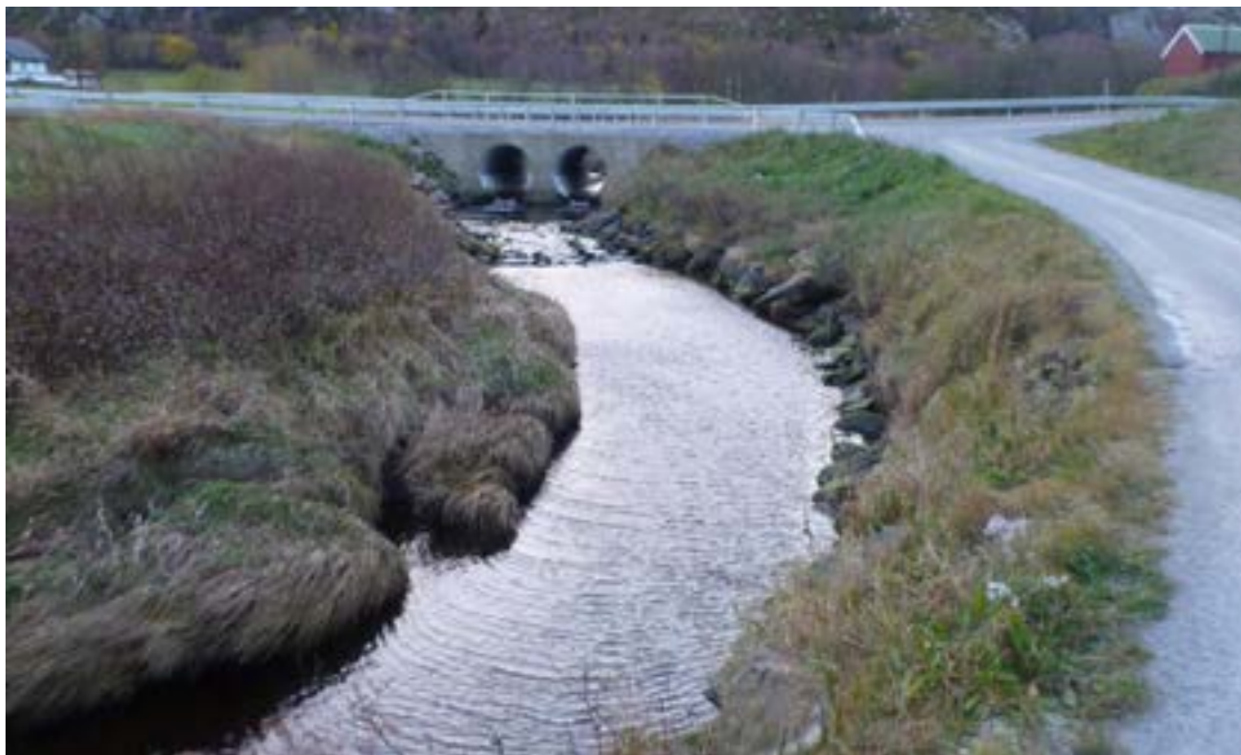
Figur 81. Bessakerelva krysser Fv. 15 i veikulvert. (Foto: Morten Bergan)
