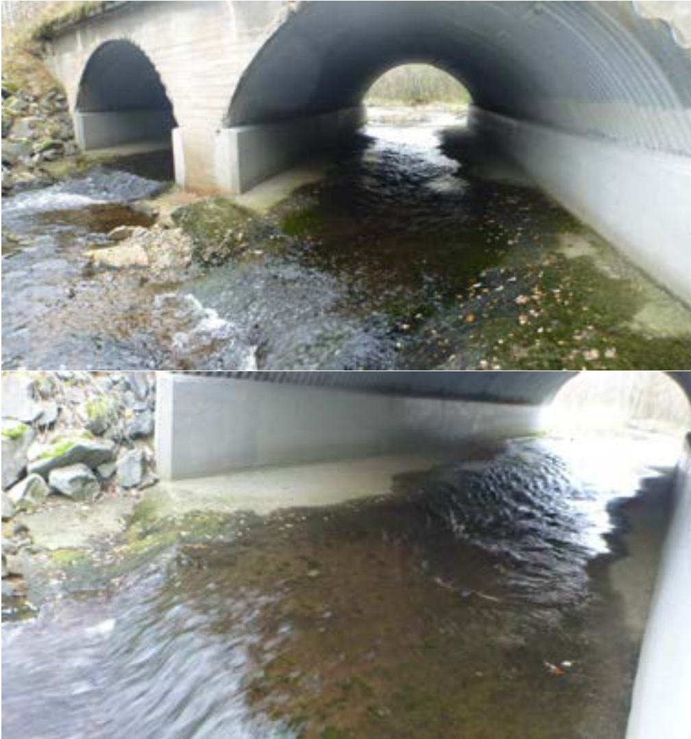
Figur 89. Veikrysning i Litlelva. Litlbrua under Fv 715. (Foto: Morten Bergan)
