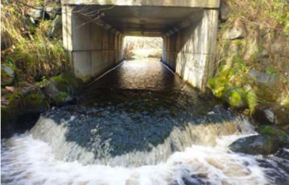
Figur 34. Krysning under Fv 231 i Eidselva på over middels/høy vannføring og mulige oppgangsforhold for sjøørret. (Foto: Morten Andre Bergan)
