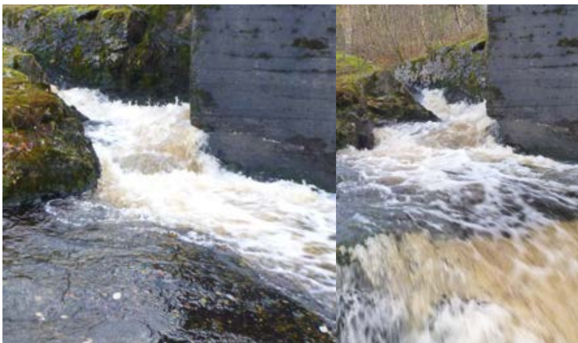
Figur 44. Oppgangsforhold ved eldre demning. (Foto: Morten Bergan)
