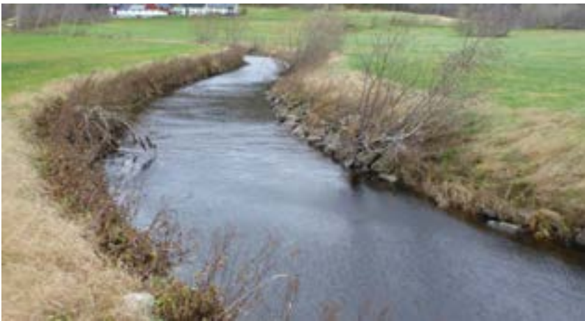
Figur 74. Betydelig utrettet og kanaliserte strekninger i Straumselva. (Foto: Morten Bergan)
