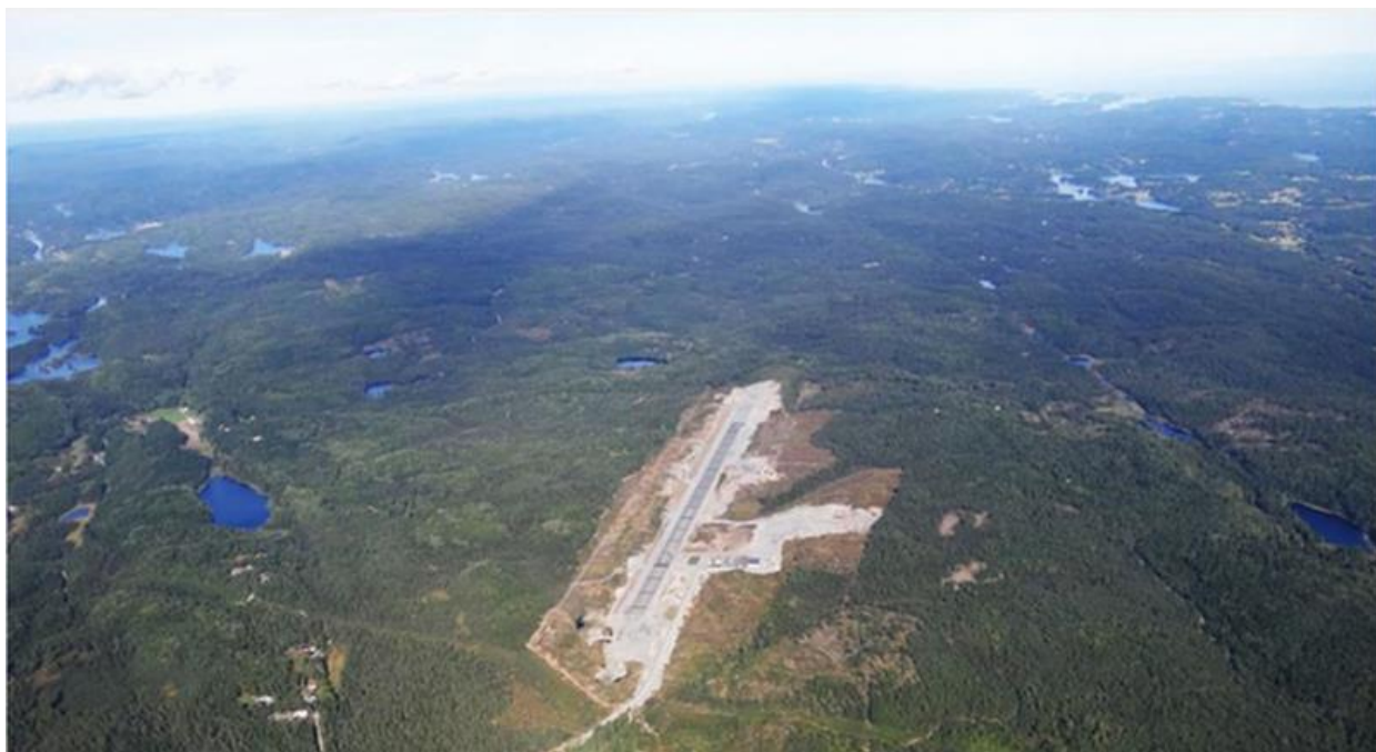
Figur 5.21 Gullknapp 2013. Anleggsarbeider pågår (foto: www.gullknapp.no )
