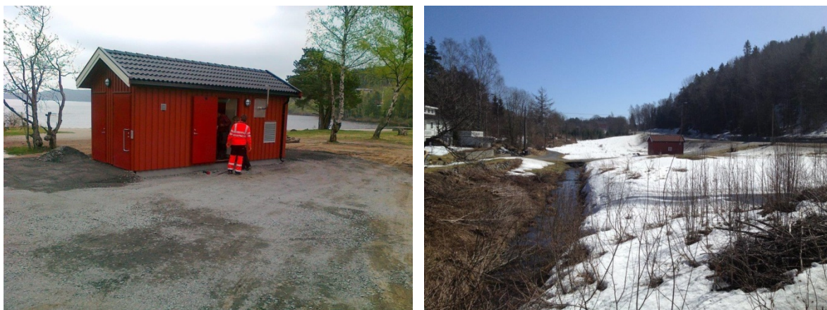
Figur 4.15 Roresanden pumpe-stasjon til venstre (foto: Dag Berge) og Naudnes pumpe-stasjon til høyre (foto: Jon Røstum).
