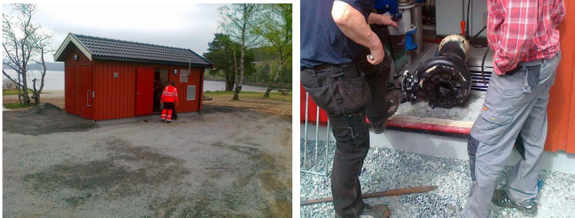
Figur 9.4 Pumpestopp og innsetting av reservepumpe ved Roresanden kloakkpumpestasjon 21.05.2013, en operasjon som vanligvis går nokså raskt. Kort avstand ned til Rore i bakgrunnen. Foto: Dag Berge.
