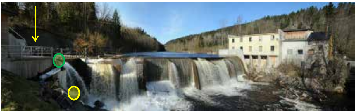
Figur 3. Dammen ved Fosstveit kraftverk fotografert i april 2012, med vanninntak til turbinen (gul pil), sideløp for nedvandrende anadrom fisk (grønn sirkel), og sideløp gjennom bunnluka for nedvandrende blankål (gul sirkel). Ål vil også kunne utvandre over damkrona når vannføringen i elva > slukeevnen ved kraftverket. Avhengig av vannføringen vil større/mindre deler av damkrona være åpne for utvandring. Foto: F. Kroglund.
