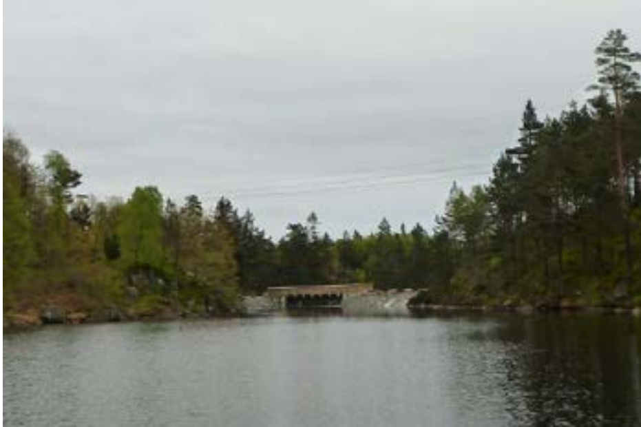
Figur 44. Linvannet. Bro laget i forbindelse med fremføringen av Skagerak 4 kabelen
