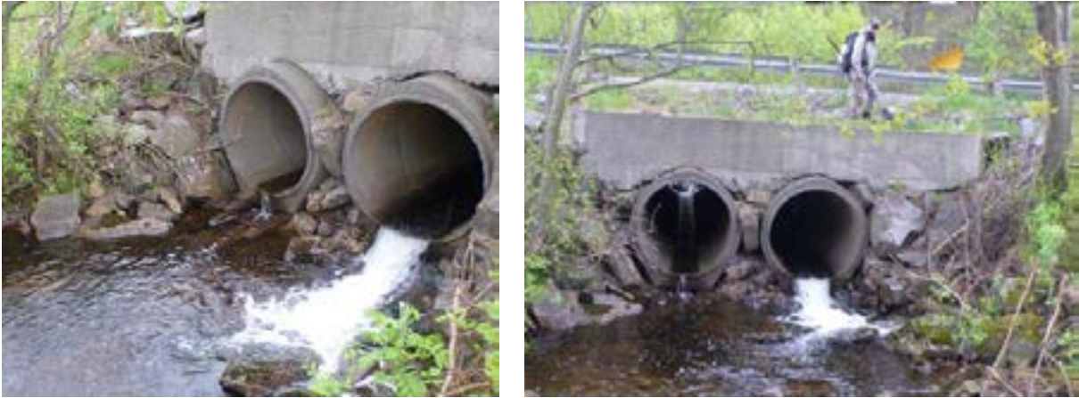
Figur33. Vandringshindrende kulvert under Torridalsveien. Foto: Karl Jan Aanes.
