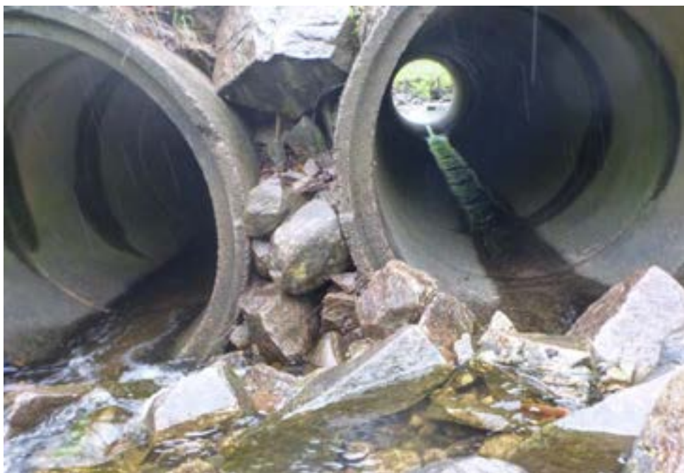
Figur 32. Kulverter under Fv 1 i Sagebekken. Foto: Morten Andre Bergan
