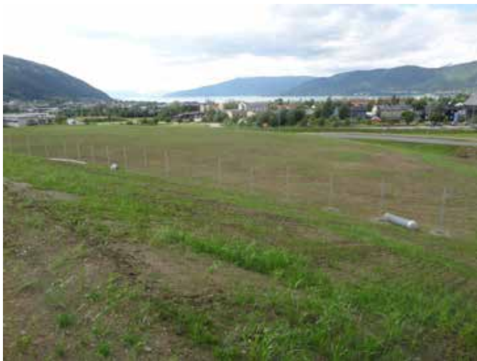
Figur 5. Bilde som viser hvordan terrengoverflaten til Deponi 2.1 fremtrer i dag etter at det impermeable toppdekket er lagt på og beplantet. Kilde: Glencore Manganese Norway.
