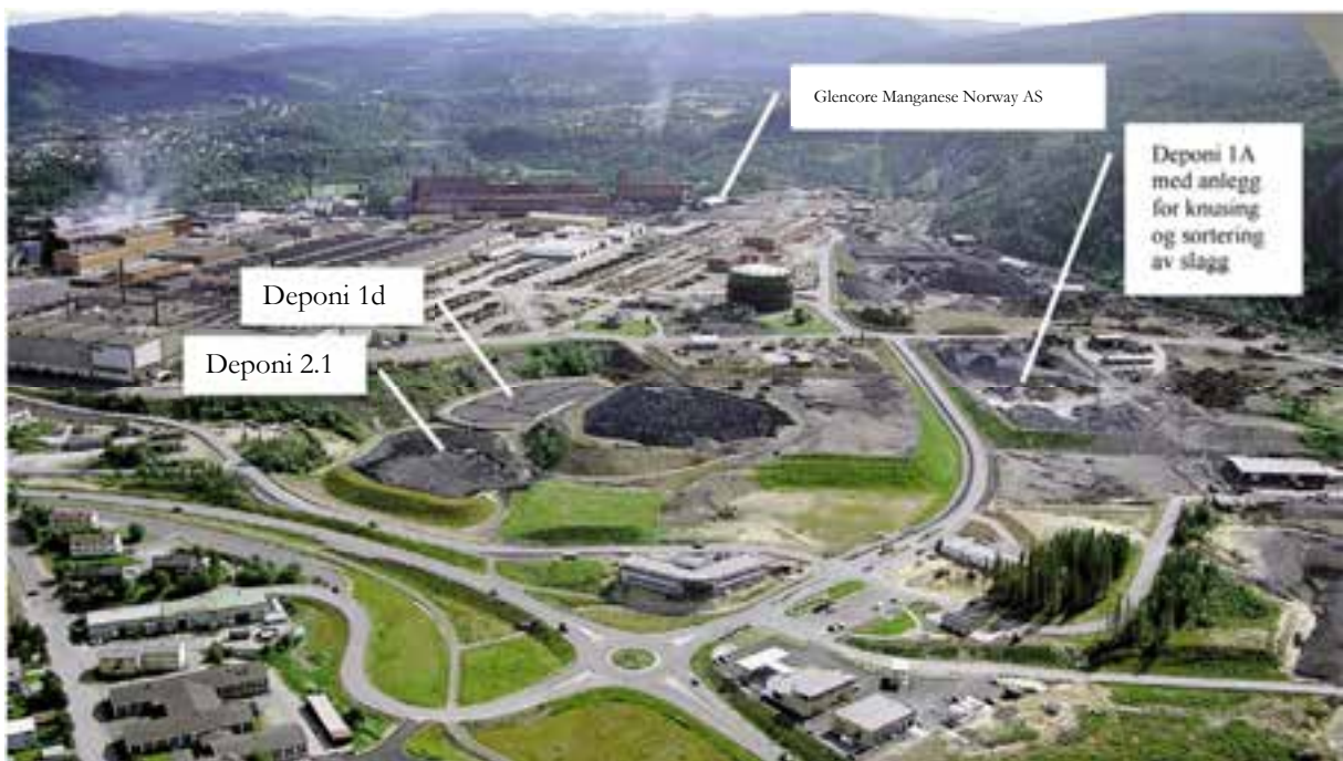
Figur 2. Oversiktsbilde som viser deponiområdet ved MIP i 2010, forut for tildekkningen av Deponi 2.1. Kilde: Glencore Manganese Norway.
