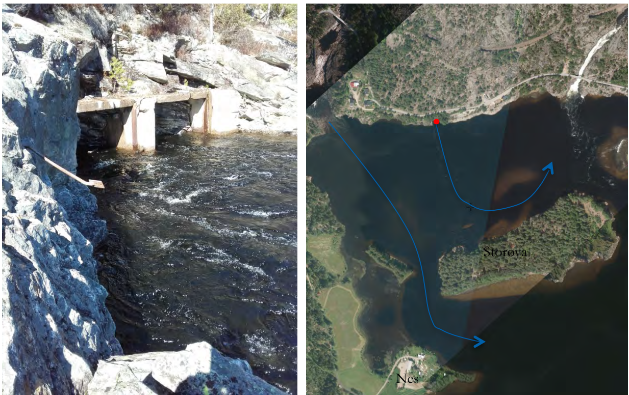
Figur 5. Venstre: Utslaget fra Hanefossen kraftverk. Høyre: Nordenden av Herefossfjorden med Hanefossen til venstre og Herefossen til høyre. Rød markering er kraftverksutslaget. Pilene antyder strømretning fra kraftverksutslaget og Hanefossen dersom det er vann i fossen ved flom. (Kilde høyre: Norkart flyfoto)
