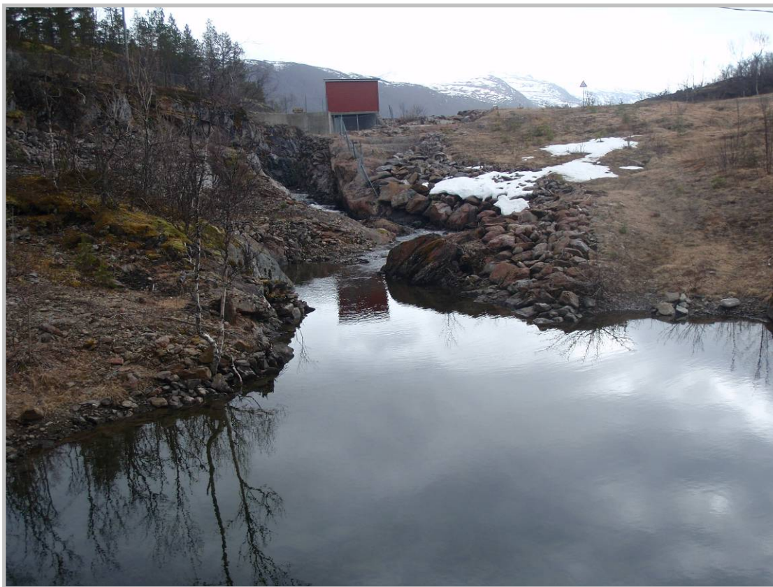
Figur 3. Foto av øvre del av referansestasjon i Børselva (Foto: M.A. Bergan)
