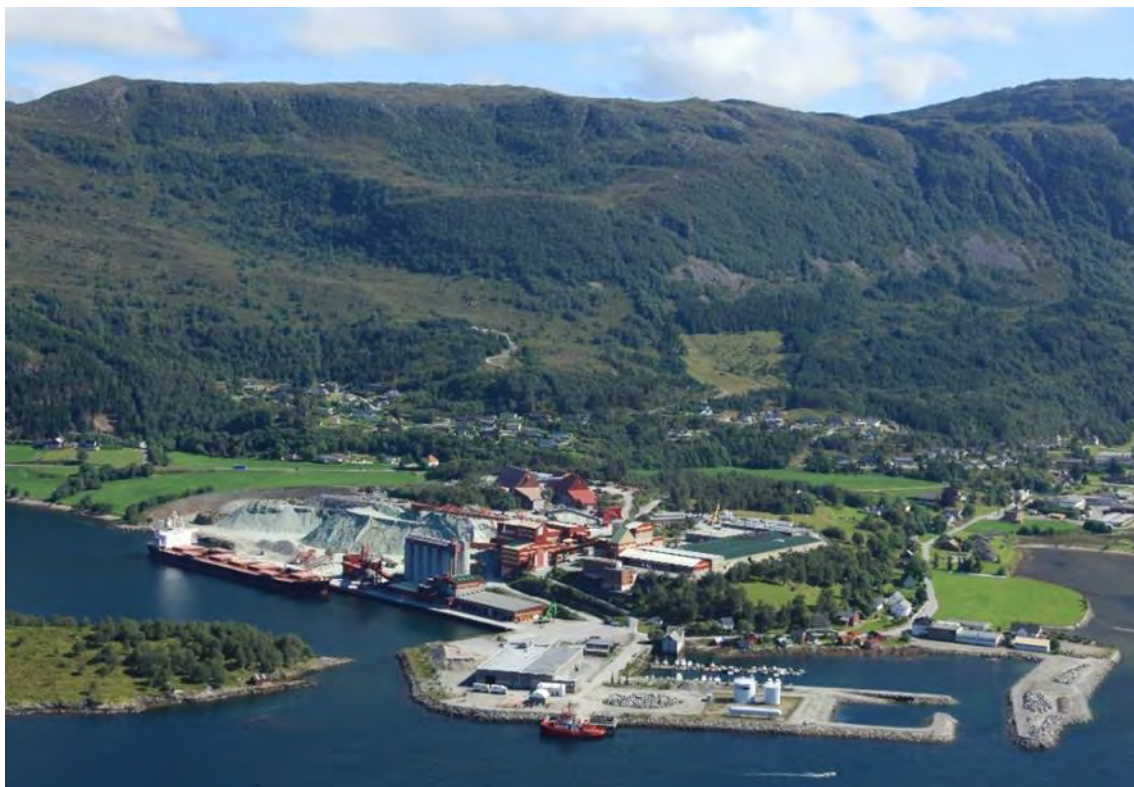
Figur 3. Flyfoto av anlegget i Åheim (Kilde Sibelco AS).
