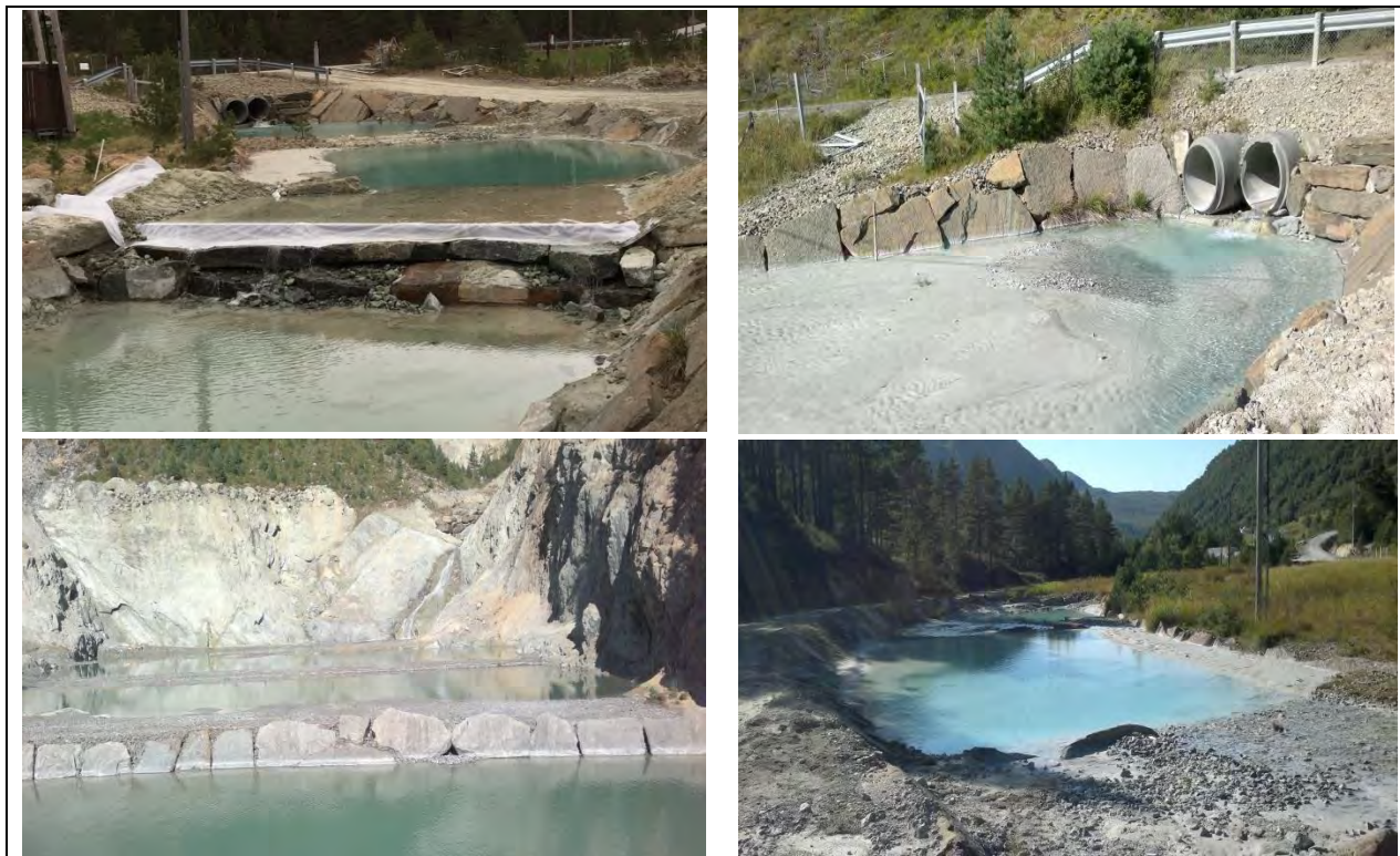
Figur 26. Ulike tiltak for å redusere transporten av uorganisk partikulært materiale fra dagbruddet i Guldalen. Foto: K. J. Aanes.
