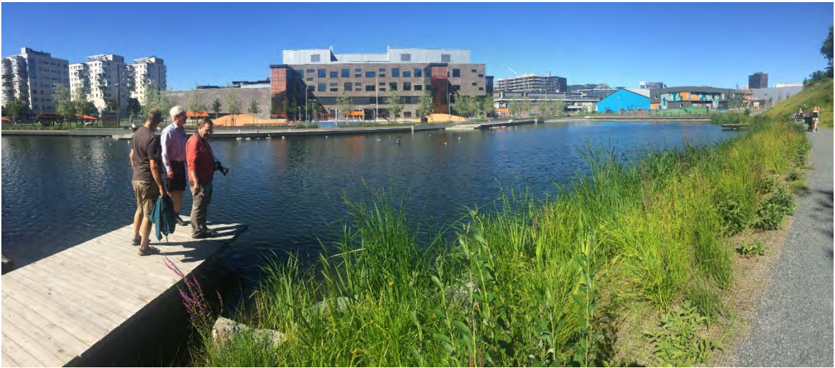
Figur 11. Anlegget Teglværksdammen er primært etablert for å forbedre vannkvaliteten og består av flere trinn med våtmarker, bekker og dammer med åpne vannspeil. Foto Trond Mæhlum/NIBIO.
