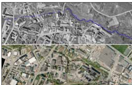
Figur 5. Flyfoto over Ladebakkens munningsområde i Trondheimsfjorden. Den siste strekningen var lagt i bakken også i 1937 og i 1957 (øverst, stiplet blå linje), men store deler av bekken var fortsatt åpen (blå heltrukken linje). I 2012 (under) skal du god fantasi for å gjette at det en gang gikk en sjørretbekk her. (Flyfoto hentet fra http://kart.finn.no/ ).
