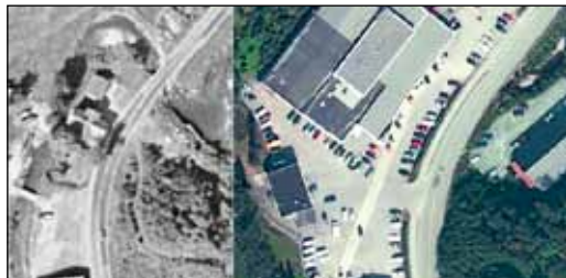
Figur 7. Den største og dypeste kulpen i Leirelva og bekkestrekninger ovenfor (t.v.) er i dag fylt igjen og lagt i rør (t.h.) ved nedre Selsbakk . (Flyfoto hentet fra http://kart.finn.no/ ).
