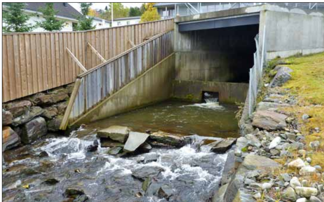
Figur 1. Hit, men ikke lenger for sjørretten i Vikhammerelva. Opptil ei mil med bekke- og elvestrekninger er redusert til rundt 200 meter i dag. (Foto: Morten Andre Bergan).
