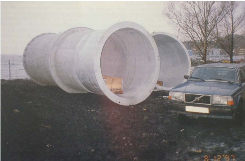
Figur 3. Bilde tatt i forbindelse med montering av overløpet i Lysakerfjorden.
