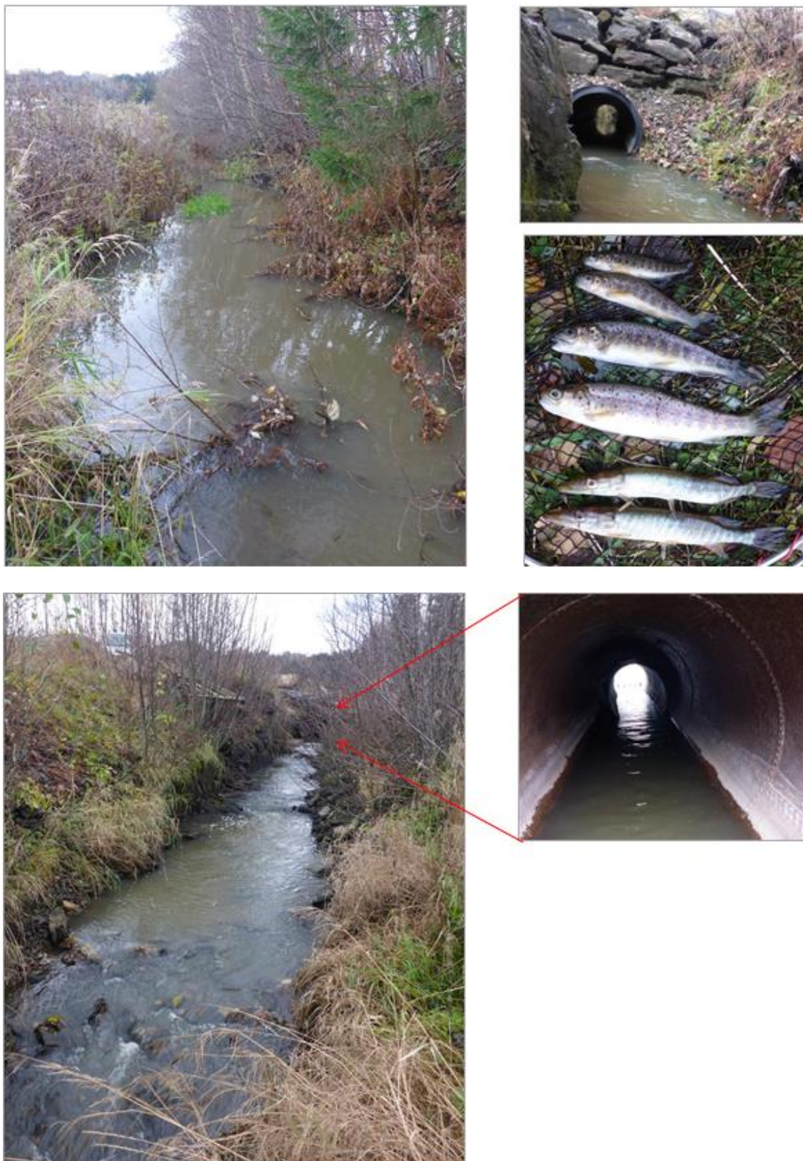
Figur 14. Låbekken på strekningen mellom kulvert under veien til idrettshall og Rødbergvegen. Bekken har her en moderat vannhastighet og stedvis stein og noe grusbunn. Kulvertene til Idrettshall (nederst t.v) og Rødbergvegen (øverst t.h) er begge paserbare for fisk. Det ble fanget 12 ørret (representert ved to årsklasser) og to gjedder (årsyngel) på denne strekningen. (Foto HBE).
