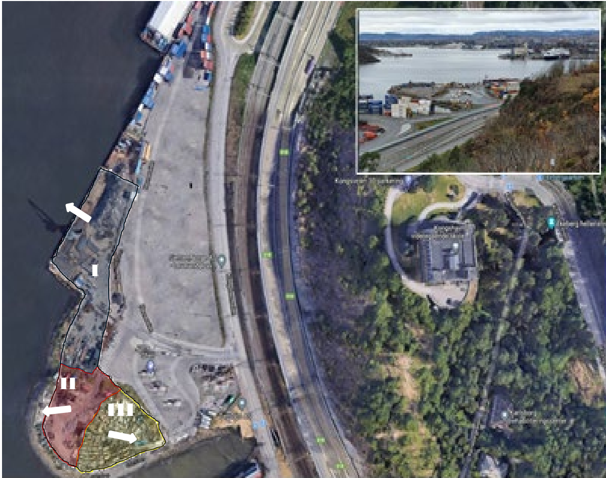
Figur 6. Flyfoto (Google maps) som viser det aktuelle området. Skanskas tomt er merket med tre seksjoner i grå (I), rød (II) og gul (III) farge. Pilene viser i hvilken retning overvann på seksjonene renner. Innfelt bilde viser området fotografert fra Kongsveien (Ekebergskråningen) (foto: Sondre Meland).
