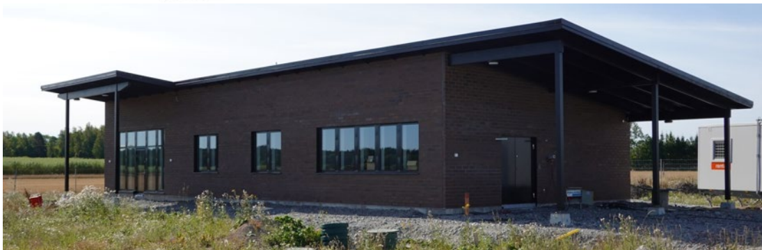
Figur 2. Bilde av teknisk infrastruktur til veistasjon E18 som den var planlagt i 2010 (øvre bilde). I dag finnes det i tillegg et stort teknisk hus som ble åpnet høsten 2020 (nedre bilde). Det tekniske huset inneholder bl.a. kontor, undervisningsrom og laboratorium (kilde: Trafikverket 8 ).
