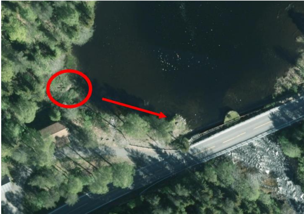
Figur 5. Flyfoto av Hauglandsfoss doseringsanlegg med bekken fra Hagetjørn som påvirker inntaket til doseringsanlegget (avmerket med pil) ved lokal flom. Kilde Norkart.
