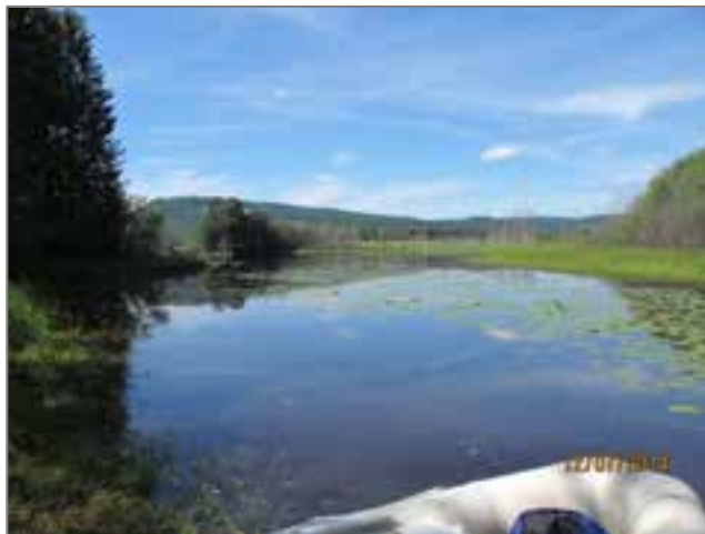
Figur 19. Flomdam sett fra sørøst. Foto: H. Edvardsen.
