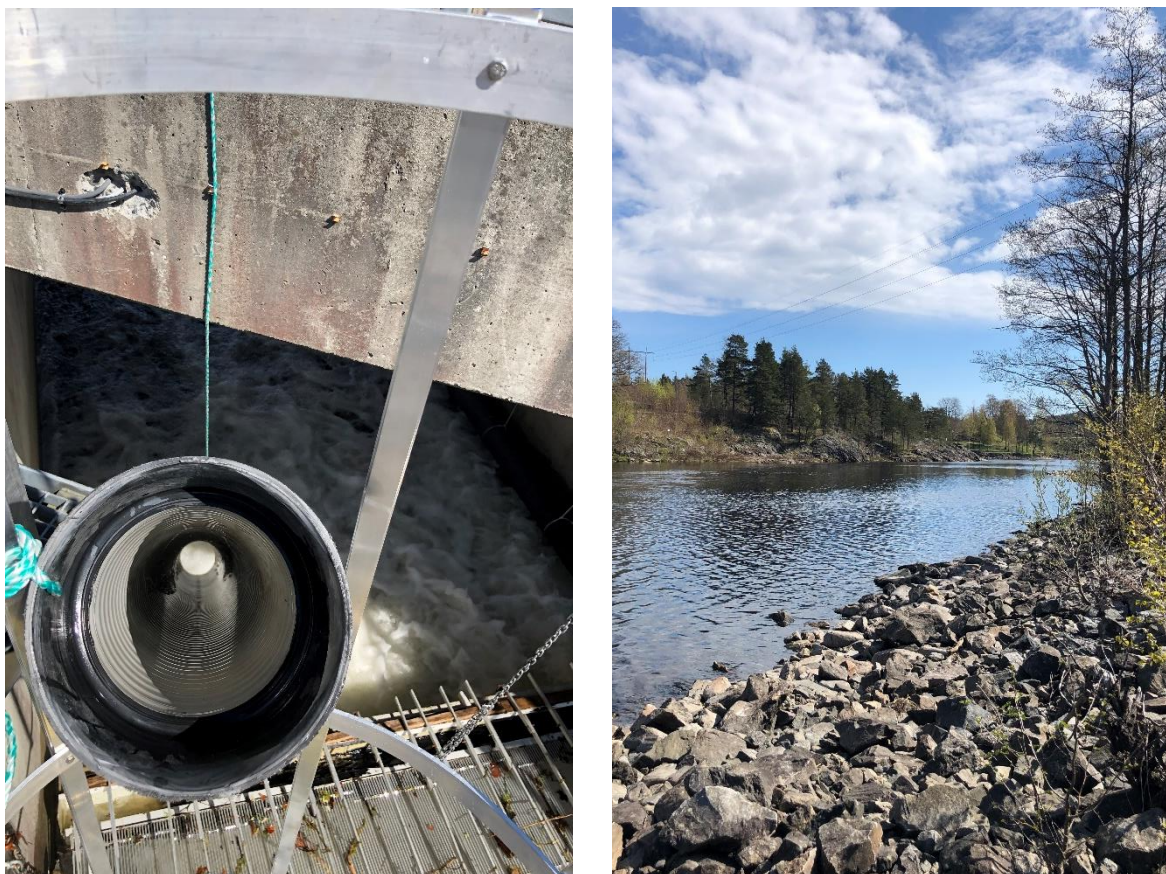
Figur 2: Utsettingssted like nedstrøms Wolf-fella i isluka (venstre) og utsettingssted «Smutten», like oppstrøms terskelbassenget ved Strubru (høyre) (Foto: Tormod Haraldstad).
