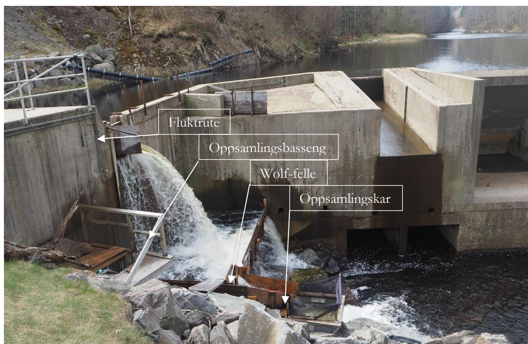
Figur 2. Fosstveit kraftverk med fluktrute for utvandrende smolt, oppsamlingsbasseng, Wolf-felle og oppsamlingskar for smolt (Foto: T. Haraldstad).
