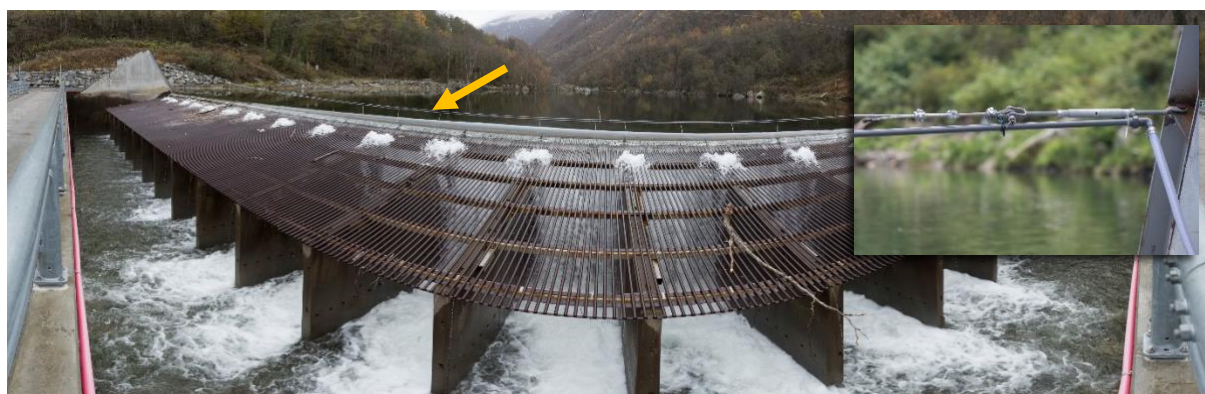
Figur 1. 180° panorama av sperrekonstruksjonen fra 2019. Dyserørene kan sees rett over brekket der vannet faller ned over sperregitteret (oransje pil). Innfelt vises ny stålvaier fra 2020. Foto: Anders Gjørwad Hagen/NIVA
