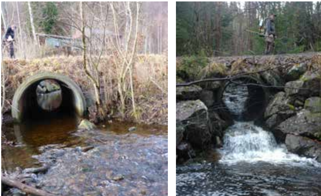
Figur 39. Songebekken har mange kulverter, noen er gode (v) andre er vandringsbarrierer (h)
