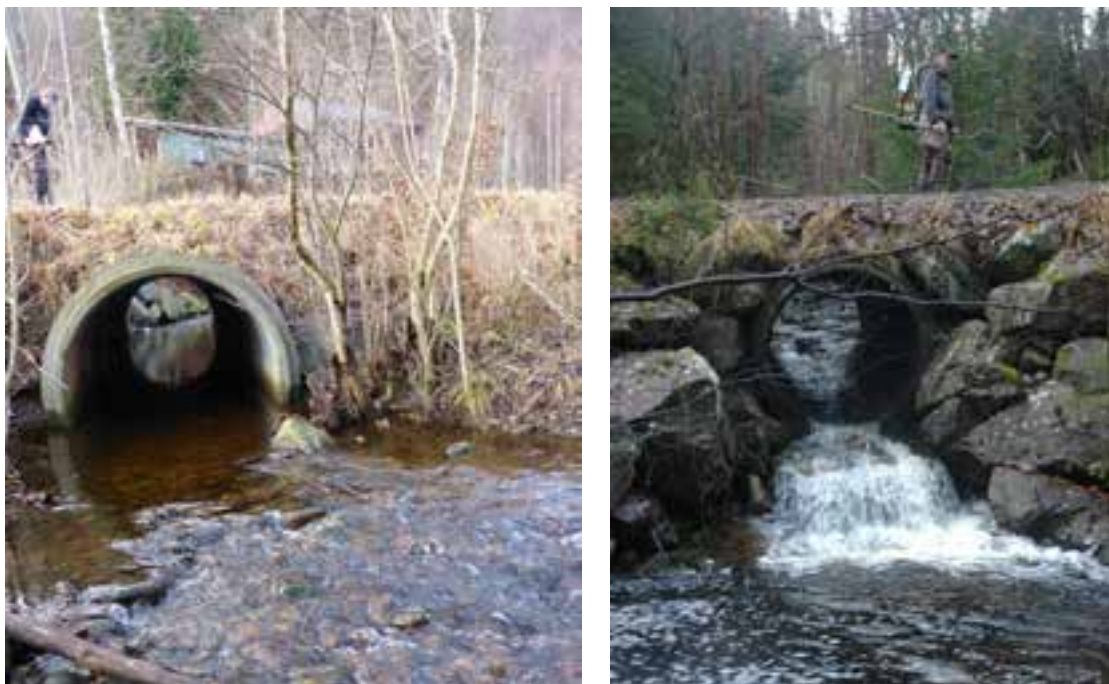
Figur 4. Songebekken har mange kulverter, noen er gode (v) andre er vandringsbarrierer (h)
