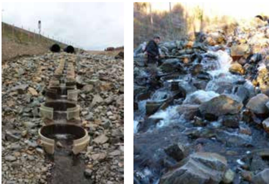
Figur 16. Fisketrapp mot kulvert under E-18 i 2010 (Gustavsen 2010) og høsten 2013.
