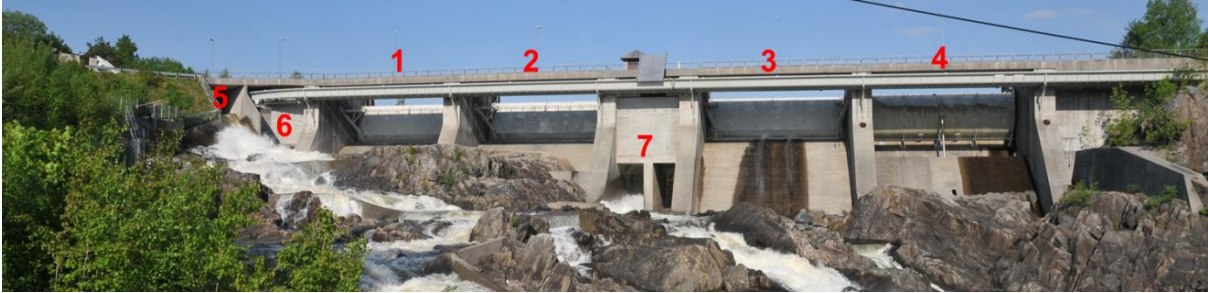
Figur 2. Dammen ved Rygene kraftverk med segmentluke (1-3), klappluke (4), Isluke (5) og fisketrapp m/sluse (6) (Haraldstad 2014).
