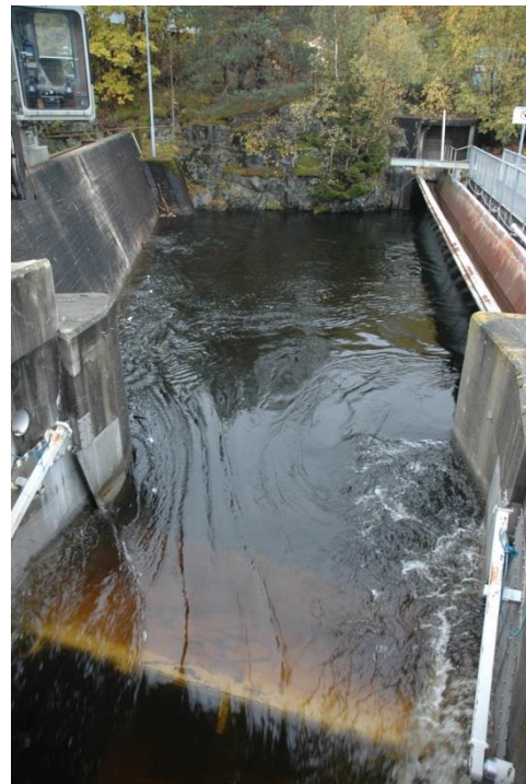
Figur 3. Forholdet mellom vannføring og vannhøyde i isluke (venstre) og isluke ved Rygene og den dykkede varegrinda.
