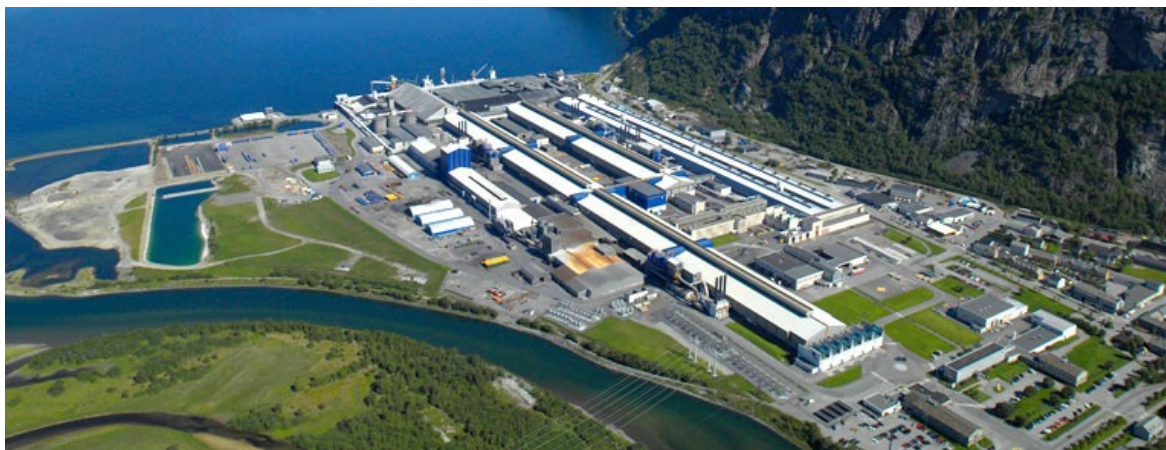
Figur 4. Oversiktsbilde av produksjonsanlegget til Hydro Aluminium på Sunndalsøra. Bilde fra Hydro.
